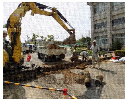
【下水道工事と一緒に進んでいます】
