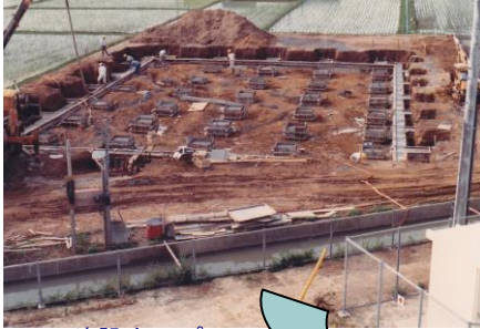
建設中のプール
